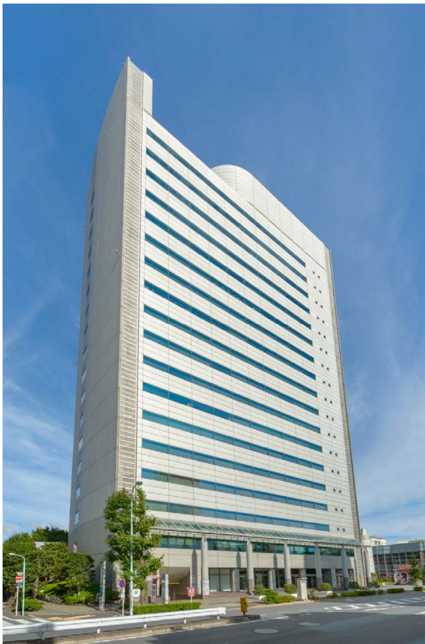
《 外 観 写 真 (高層棟) 》
