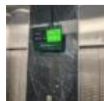
デジタルサイネージ設置 (Daiwa銀座ビル)
