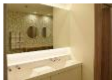
衛生機器の改修 ( Daiwa品川御殿山ビル )
