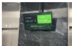
デジタルサイネージ設置 ( Daiwa銀座ビル )
