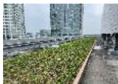
屋上緑化の推進 ( コンカード横浜 )
