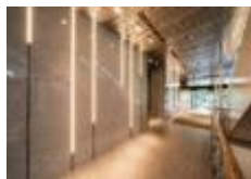
共用部改修に伴うLED導入 ( Daiwa笹塚タワー )
