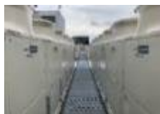
空調設備の更新 ( Daiwa銀座ビル )
