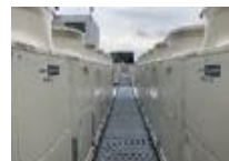
空調設備の更新 (Daiwa銀座ビル)
