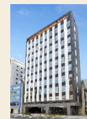
日本橋馬喰町一丁目開発PJ (現Daiwa日本橋馬喰町ビル) 2022年11月竣工
